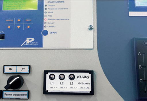
Рис. 31. Индикатор наличия напряжения в составе шкафа КРУ «Элтима»
