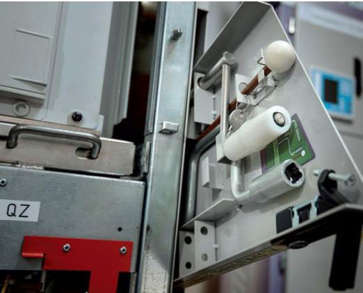
Рис. 42. Рукоятки перемещения КВЭ, заземлителя и ручного отключения выключателя
