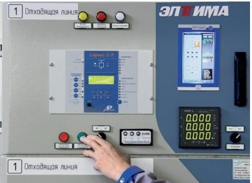
Рис. 30. Отсек вспомогательных цепей
