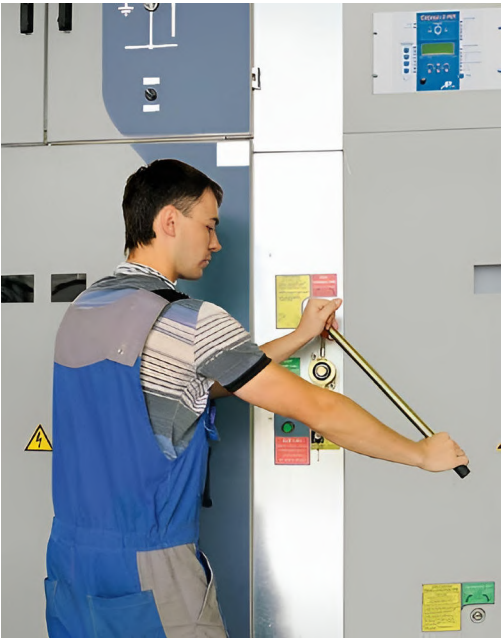
Рис. 12. Оперирование заземлителем
