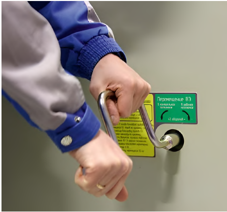
Рис. 9. Перемещение ВЭ внутри отсека
