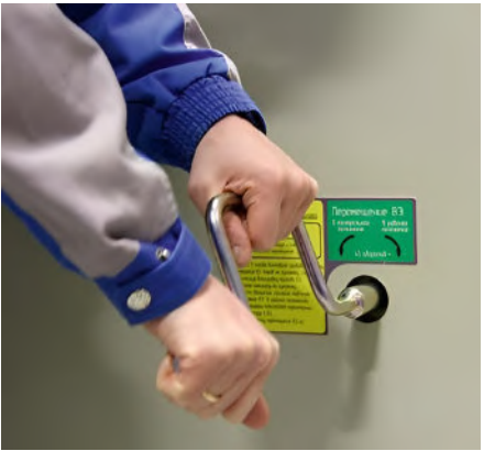
Рис. 9. Перемещение ВЭ внутри отсека
