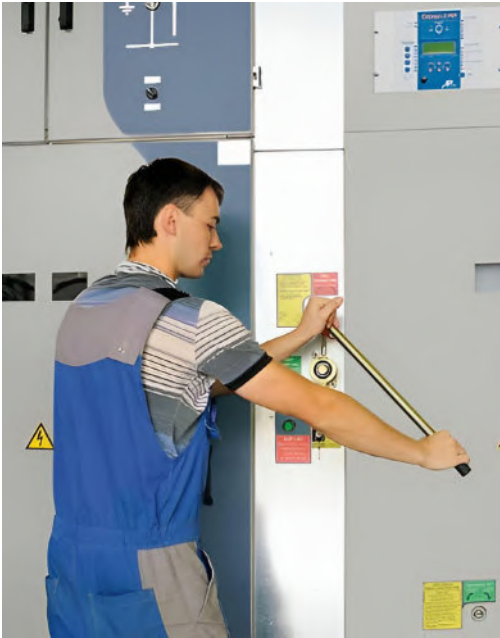
Рис. 12. Оперирование заземлителем
