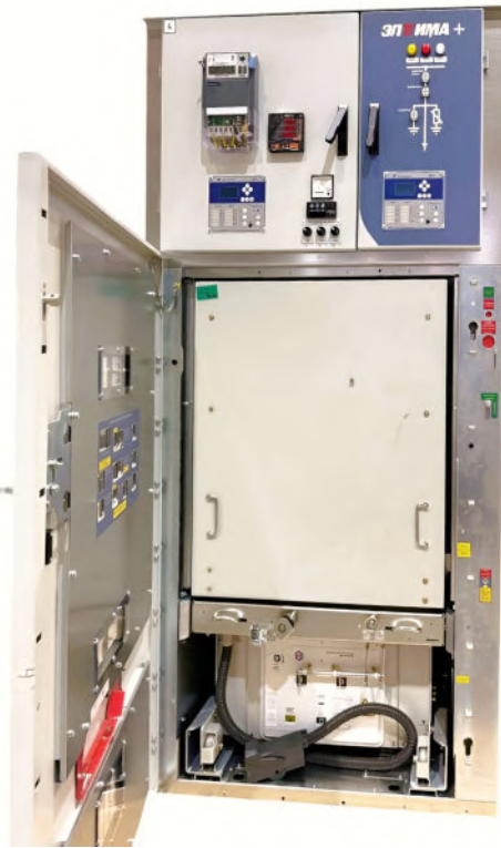
Рис. 6. КРУ «Элтима+» с ВЭ в контрольном положении
