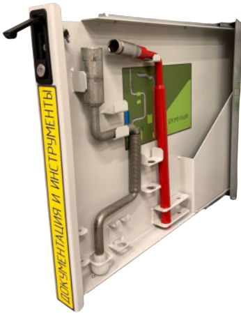
Рис. 42. Рукоятки перемещения КВЭ, заземлителя и ручного отключения выключателя
