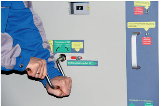
Рис. 20. Перемещение КВЭ внутри отсека
