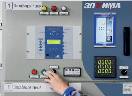
Рис. 30. Отсек вспомогательных цепей
