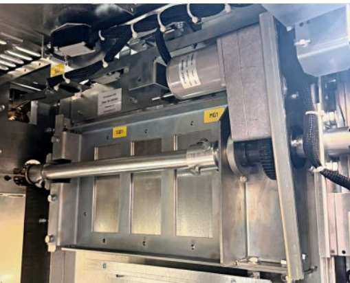
Рис. 25. Моторизированный привод заземлителя
